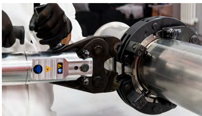
Figura 39- Assemblaggio pressatura n°1
