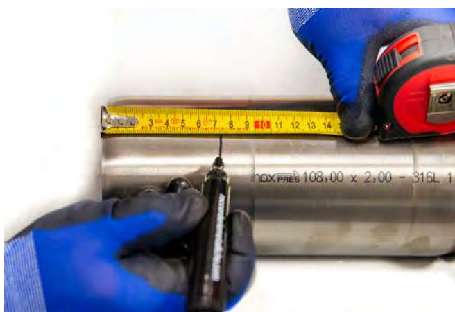
Figura 28 - Marcatura della profondità d'innesto con metro
