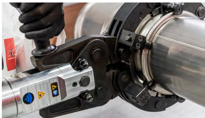
Figura 40 - Assemblaggio pressatura n°2
