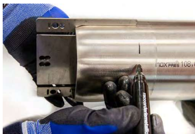
Figura 29 - Marcatura della profondità d'innesto con marcatore Ø 76 mm - Ø 88 mm - Ø 108 mm
