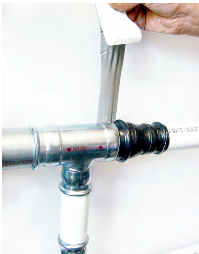
Figura 43 - Protezione dei raccordi con nastro isobutilico
