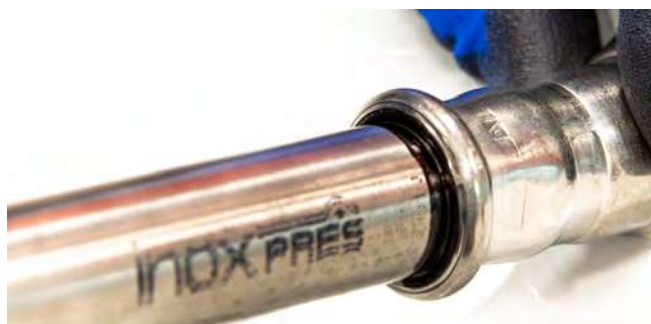
Figura 33 - Esempio di errata marcatura
