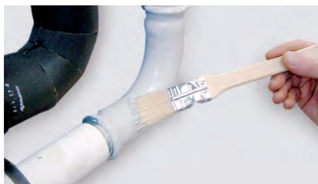
Figura 42 - Verniciatura raccordi e tubazioni con primer
