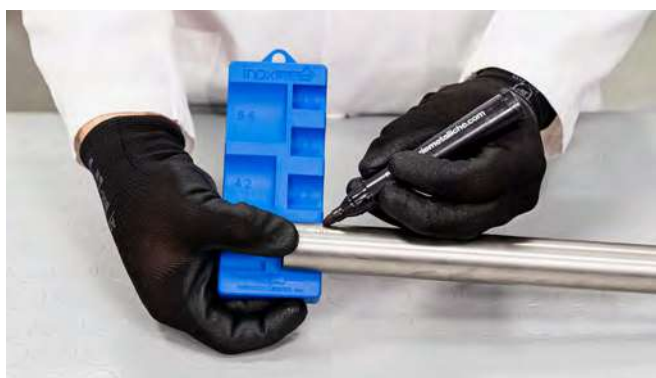
Figura 30 - Marcatura della profondità d'innesto con marcatore con \varnothing 15 - 54 mm
